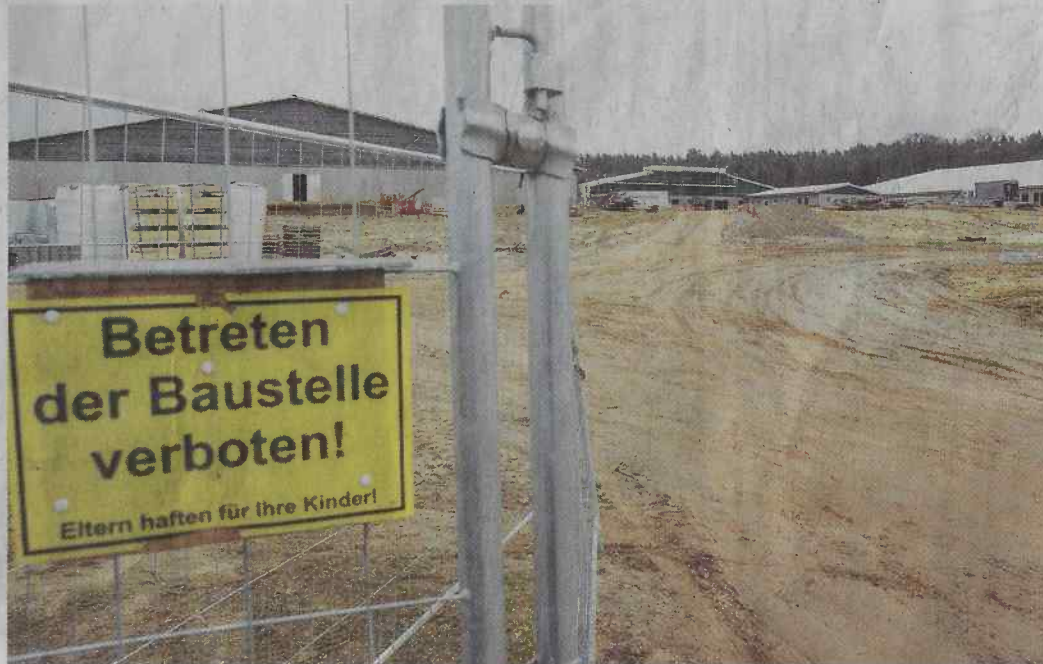
So sah es auf der BHZP-Baustelle in Ellringen zum Zeitpunkt des Baustopps aus. Jetzt wurde der B-Plan überarbeitet. Foto: A/t&w
