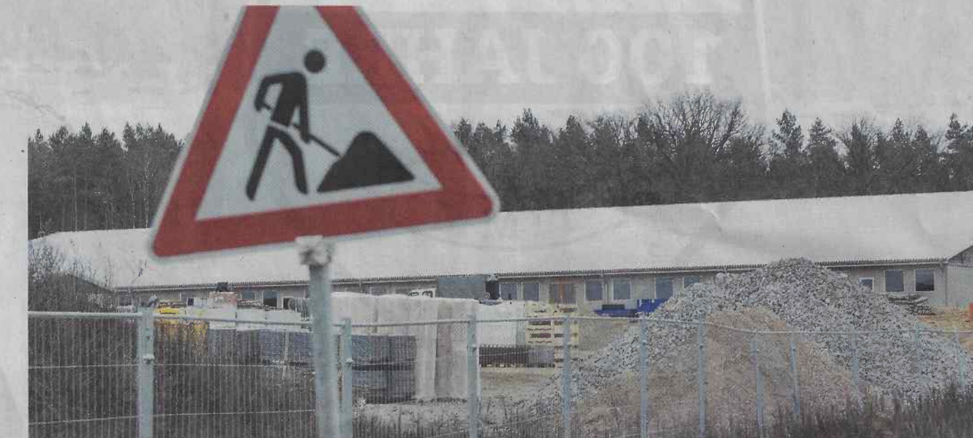
So sah es auf der Baustelle der BHZP vor einem Jahr aus. Seitdem hat sich durch den Baustopp nicht mehr viel getan. Foto: A/t&w
